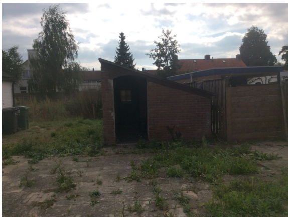
Figuur 6: Overzichtsfoto bebouwing
