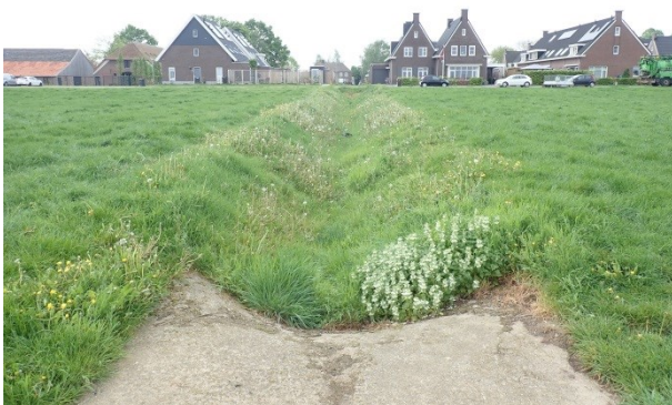
Foto 3: de zaksloot/ wadi gezien in de richting van het Schuttersveld. Deze sloot ligt midden in het plangebied en sluit aan op de watervoerende sloot.
