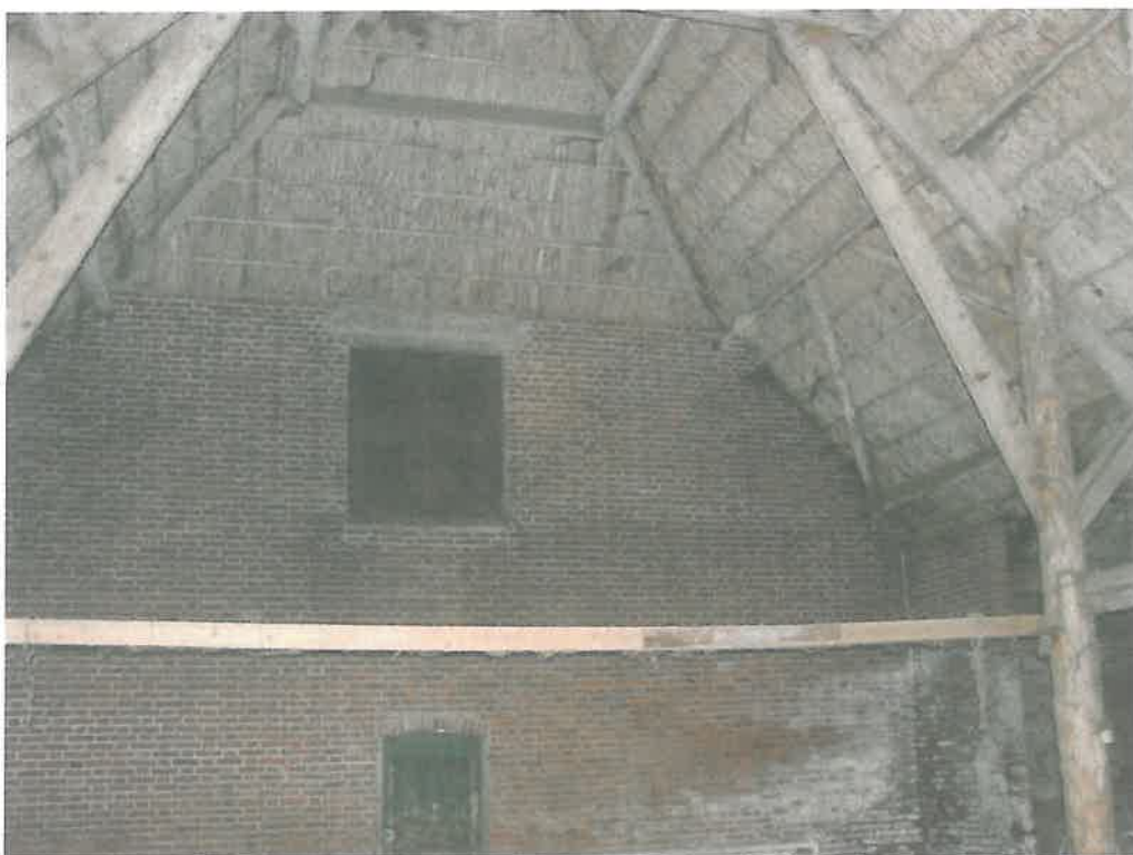
Foto 6. Binnenzijde open kapschuur
