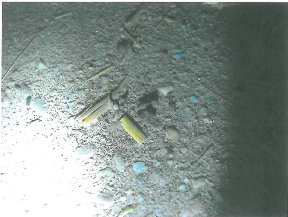
Foto 4. Uitwerpselen vleermuizen op vloer open kapschuur
