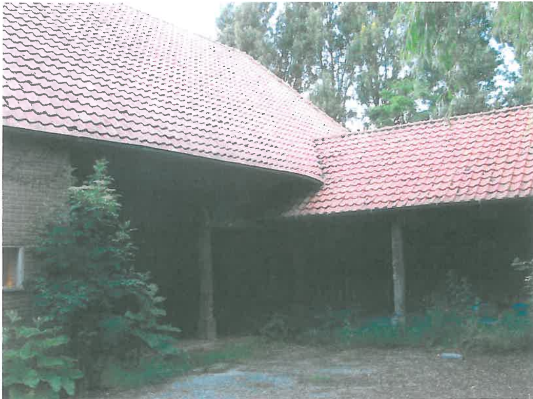
Foto 7. Buitenzijde open kapschuur
