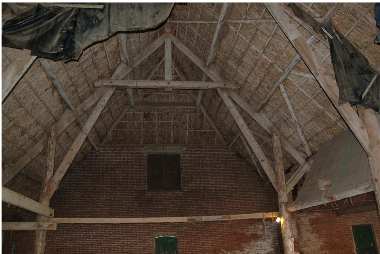
Interieur stal met kaspanten
