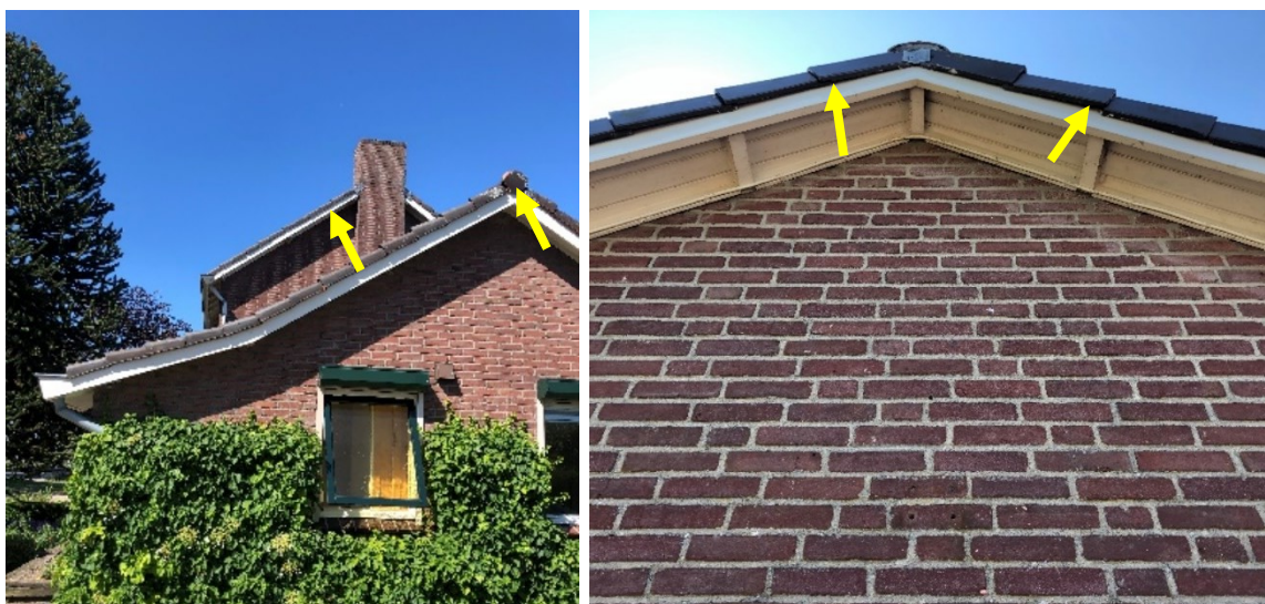
Figuur 5. Enkele voorbeelden van ruimtes onder de kantpannen en nokvorst die geschikt zijn voor gebouwbewonende vleermuizen (gele pijlen).
