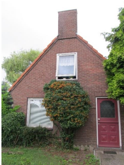
Foto 1 Voorgevel van het huis.
