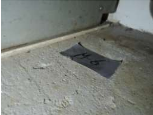
Het plaatmateriaal onder de CV-ketel in de woning bevat geen asbest (M-6).
