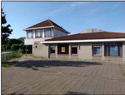
Schoolgebouw gezien vanuit het oosten
