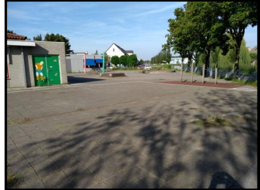
Schoolgebouw gezien vanuit het oosten
