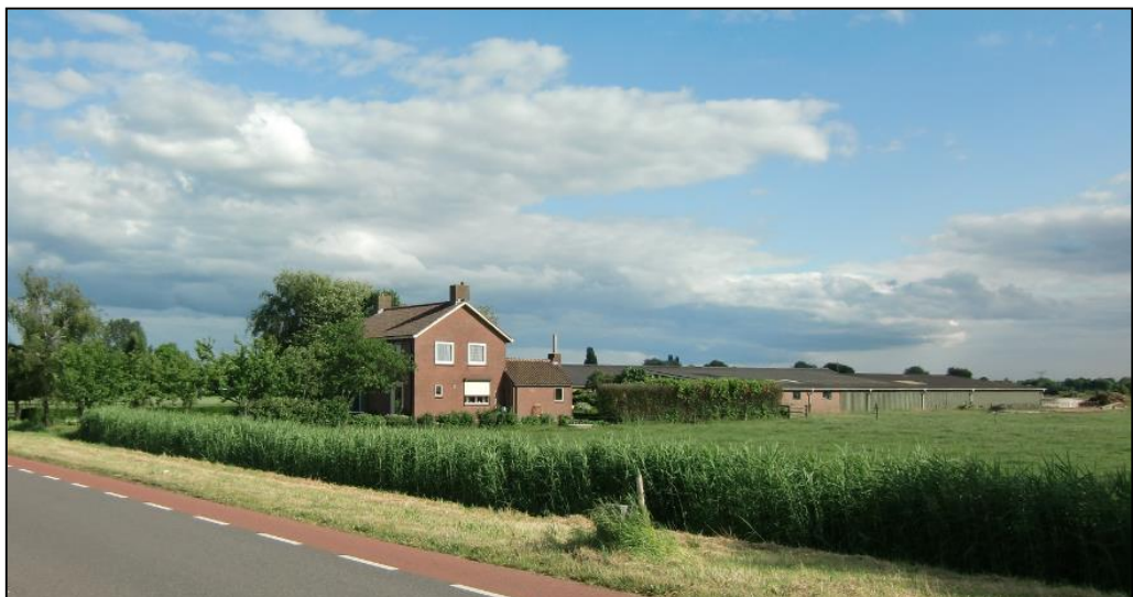
Zicht op deelgebied zuid met links de bedrijfswoning en rechts de voormalige bedrijfsbebouwing
