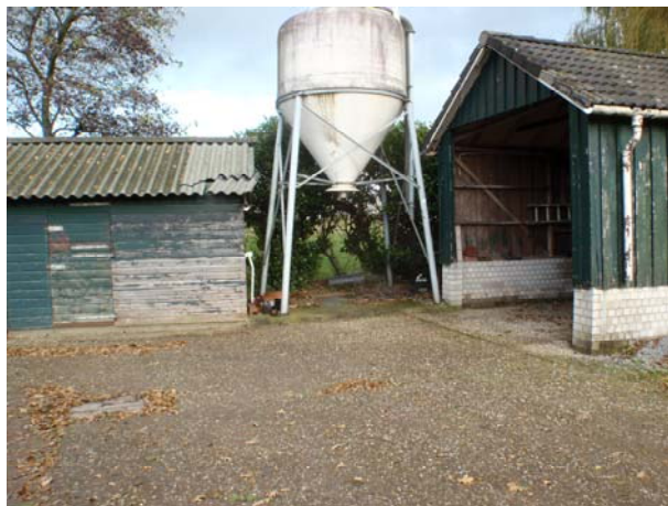
Afbeelding 14: Opstallen met asbestverdacht materiaal
