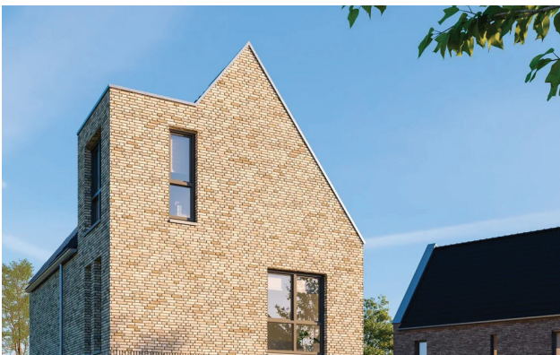
overgang de hoek om - dakopbouw
