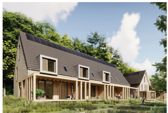
dakkapel als losse elementen toegevoegd
