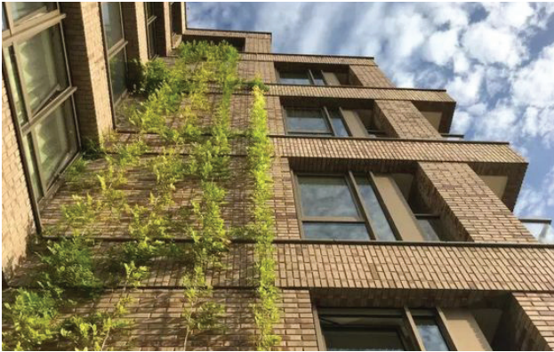
(5) beplanting op de gevel
