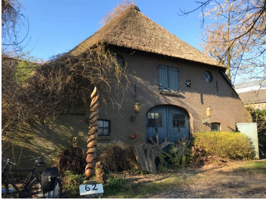
Voorzijde bebouwing (noordzijde)
