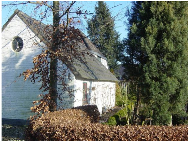
Foto 1: De te slopen atelierruimte gezien vanuit de zuidwest zijde. Op de foto zijn de goed afgesmeerde kantpannen en nok zichtbaar.
