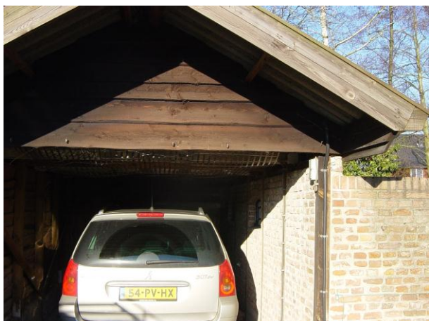
Foto 4: de carport met rechts de massieve halfsteens muur
