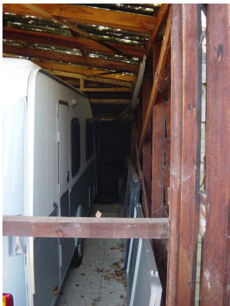
Foto 6: binnenzijde caravanstalling, gepotdekselde wanden met een dak van glasvezelplaten.
