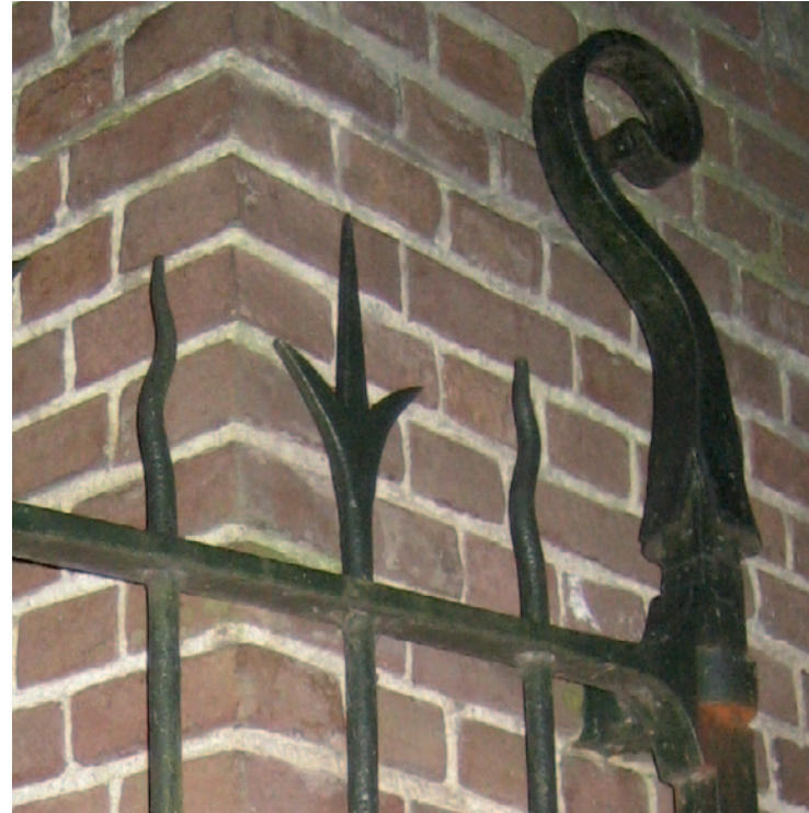
bestaande poort - detail
