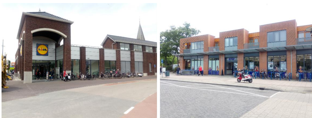
FIGUUR 7 HUIDIGE LIDL AAN DE KASTANJELAAN EN VOORMALIGE LIDL AAN DE RIJKSWEG, MOMENTEEL INGEVULD DOOR ACTION
