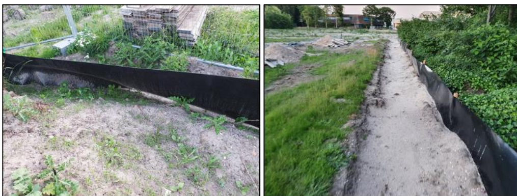
Figuur 3 Een incorrect geplaatst amfibiescherm (links). Een correct geplaatst amfibiescherm (rechts). Deze dienen minimaal 10 cm ingegraven te zijn.
