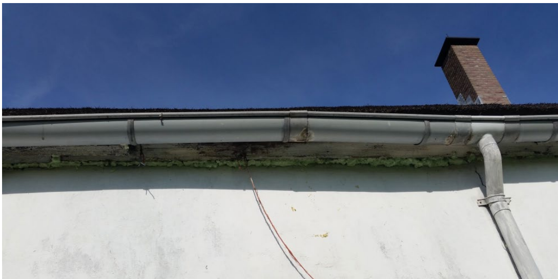
Openingen en gaten in de woning afgesloten met purschuim.
