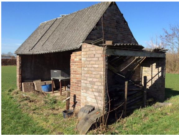
Figuur 8: Overzichtsfoto bebouwing
