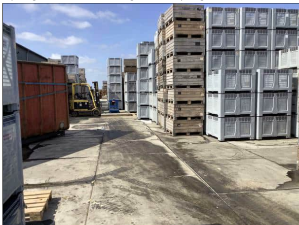
Foto 5 Overzicht stelconplaatverharding met opslag
