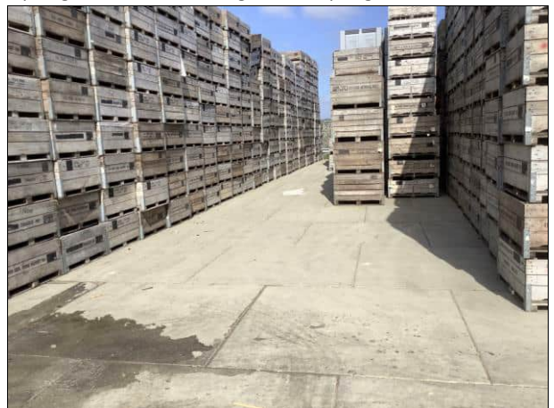
Foto 6 Overzicht stelconplaatverharding met opslag
