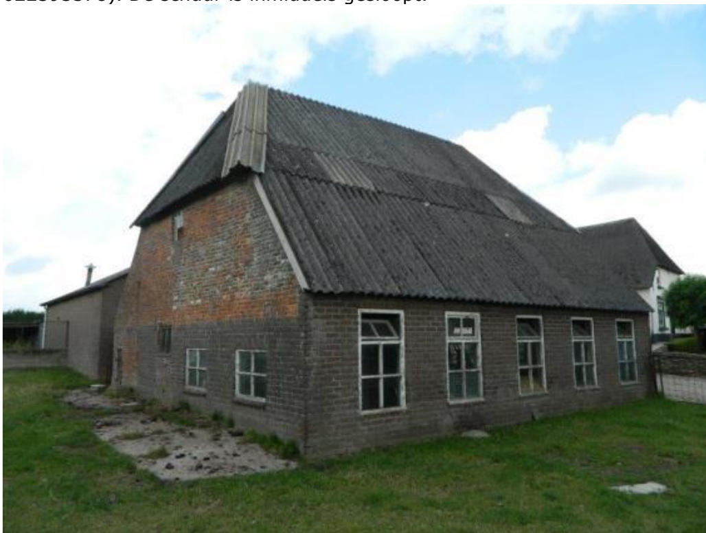
Foto: Gesloopte schuur.
