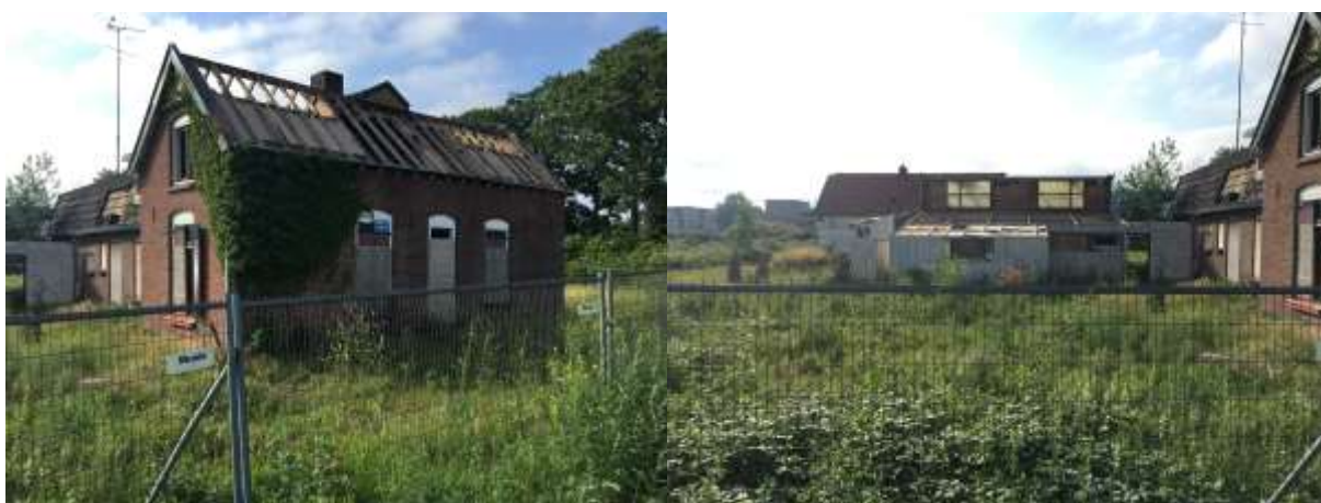
Aanzicht op de te slopen bebouwing in het plangebied (juni 2021).
