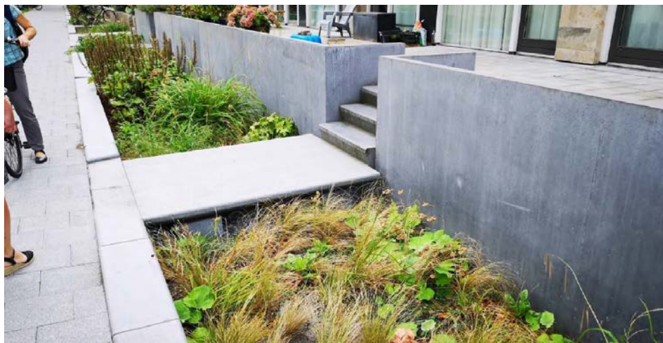
Regentuinen vangen het regenwater van de daken op en laten het vertraagd infiltreren
