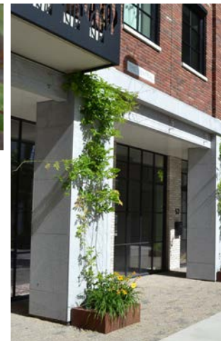
Gevelbegroeiing d.m.v. spandraden
