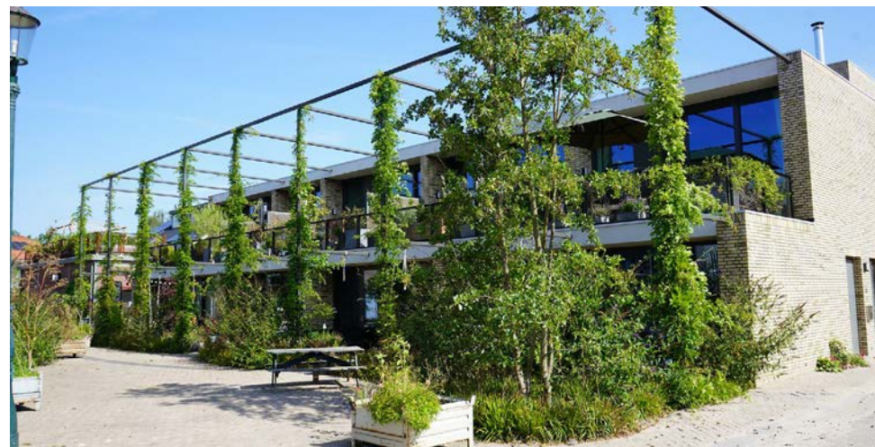
Pergolaconstructie boven dakterras: schaduwwerking en privacy
