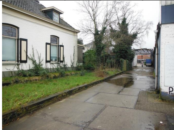
Vanuit noordoostelijke richting nabij boring 4
