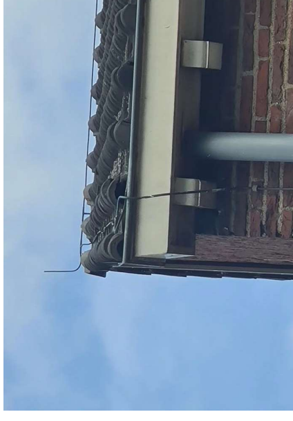
Figuur 19: Ruimte onder de dakpannen in het zuiden van de bebouwing aan Hoog Hagen 6
