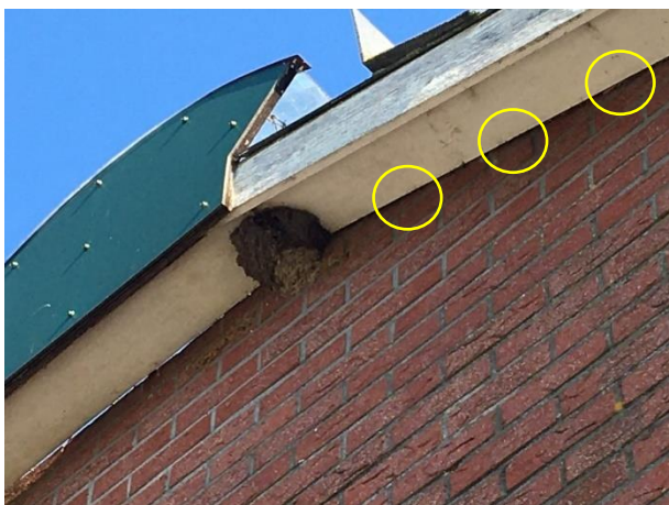
Er zijn kieren (gele cirkels) waargenomen tussen de betimmering van het dak overstek en de buitengevels van de ligboxenstal.
