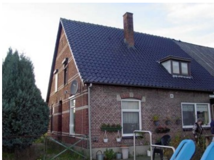
Figuur 13: foto van het pand Bleeksestraat 8
