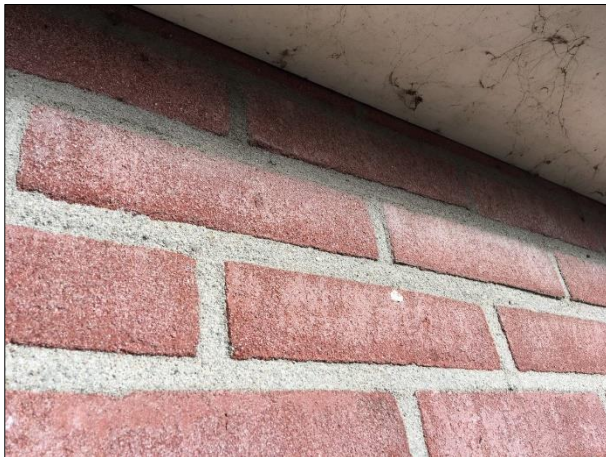
De betimmering van het dakoverstek van de corridor sluit naadloos aan op de buitengevels.
