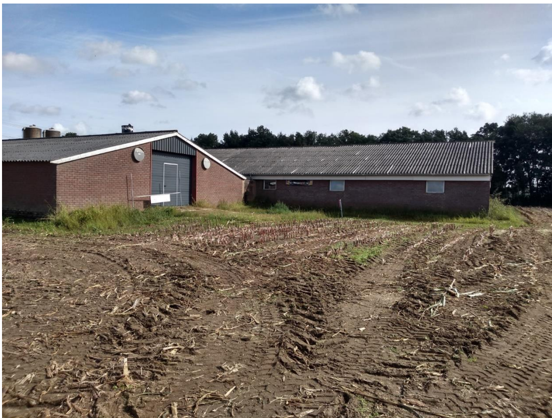
Afbeelding 13 en 14: Foto (boven) van het verharde erf ter hoogte van boring 3 richting het zuiden en Foto (onder) van de locatie van boring 1 richting het oosten.
