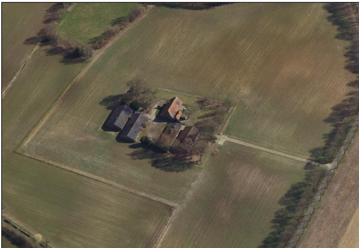
Afbeelding, bouwlocatie Pinnedijk 11 (Bron: Street Smart) 10-3-2022
