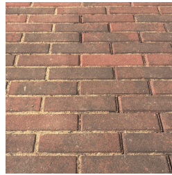
Betonklinkers wandelpaden met nutstracé eronder
