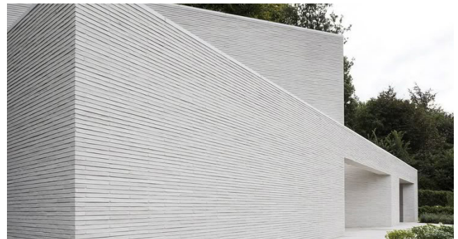
Referentiebeelden monolite gevels Welkomsgebouw
