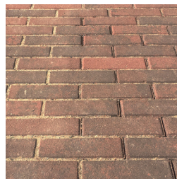
Betonklinkers wandelpaden met nutstracé eronder
