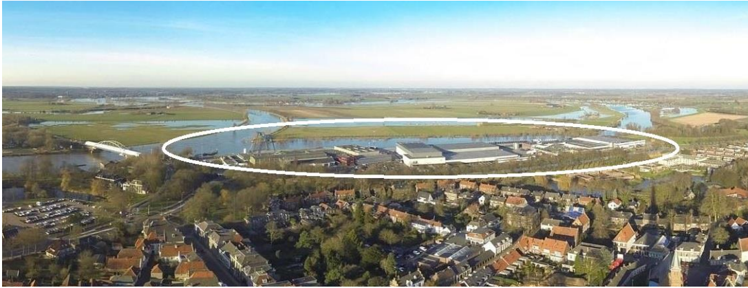
Figuur 2-1 | Panorama view huidige situatie bedrijventerrein en omgeving (bedrijventerrein: wit omcirkeld; bron: Doesburg2030.nl)
