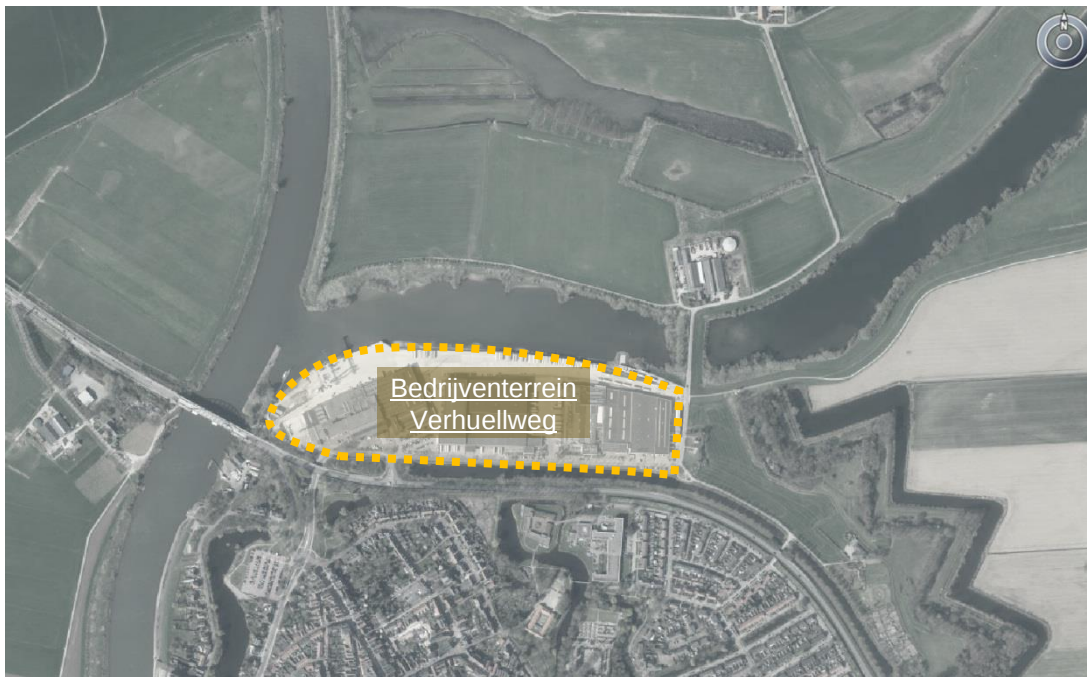
Figuur 1.1 - Ligging bestaand bedrijventerrein Verhuellweg (Luchtfoto: CycloMedia, 2017)
