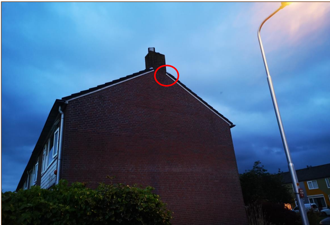
Foto 1. Locatie verblijfplaats gewone dwergvleermuis Van Tuylplein 18 (rode cirkel).
