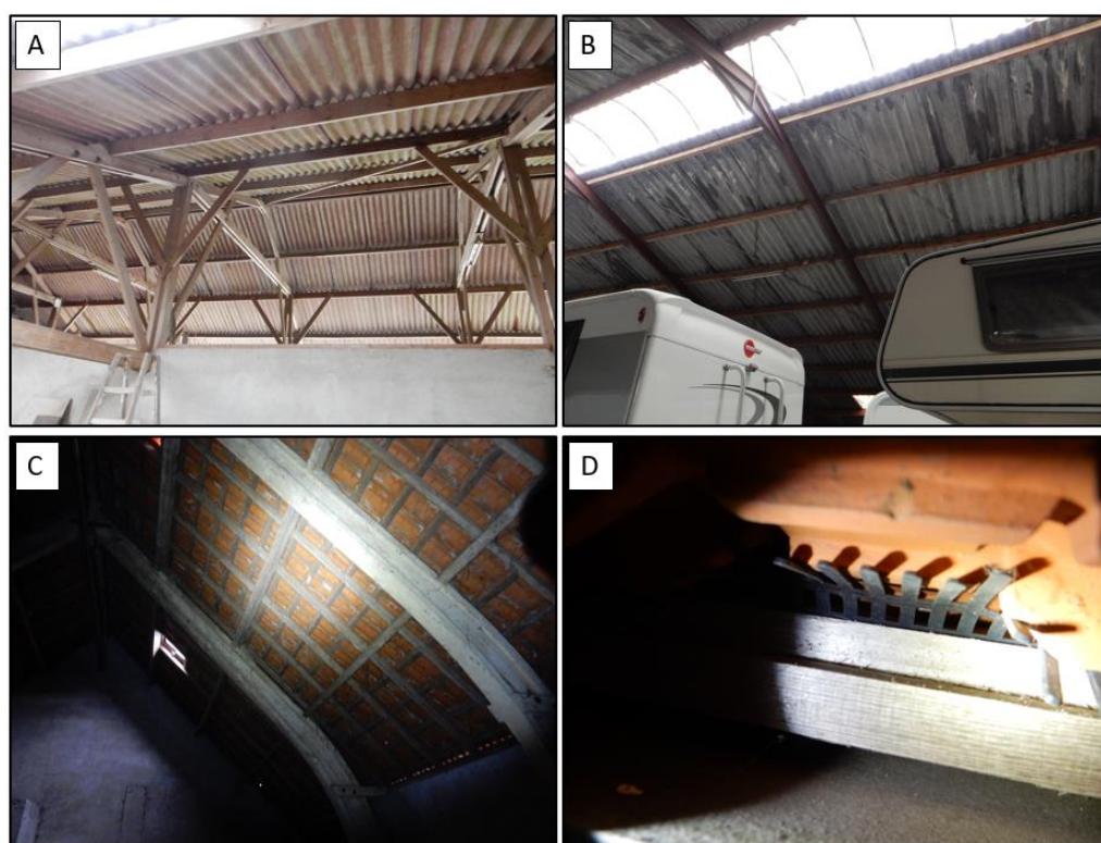
Figuur 5 Visuele representatie van de daken op de planlocatie. (A) het dak van de kapschuur bestaat uit golfplaten. (B) het dak van de ligboxenstal bestaat uit golfplaten. (C) de zolder van bijgebouw 2 bestaat uit een pannendak zonder dakbeschot. (D) de bijgebouwen zijn voorzien van vogelwerend materiaal. De ruimte onder de houten lat is slechts 1 cm en derhalve niet geschikt voor huismussen.
