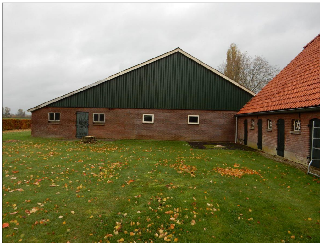
Figuur 1 De kapschuur (links) en bijgebouw 1 (rechts) op de planlocatie.
