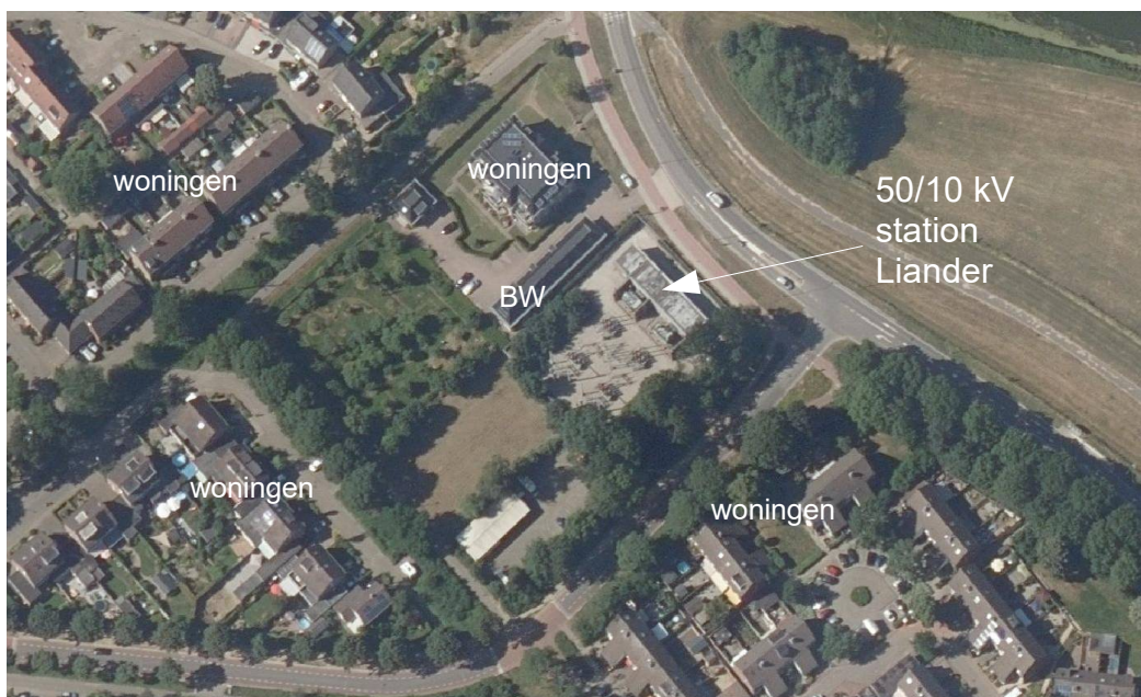
f2.1 Situering 50/10 kV-onderstation Angelo en woningen in de omgeving
