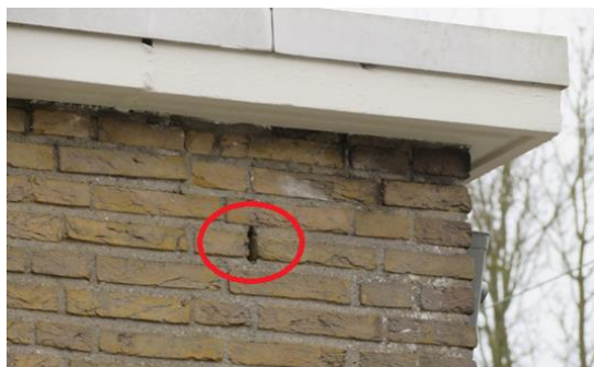
Fig 6: Close-up van open stootvoeg. Tussen daklijst en muur zitten geen kieren.
