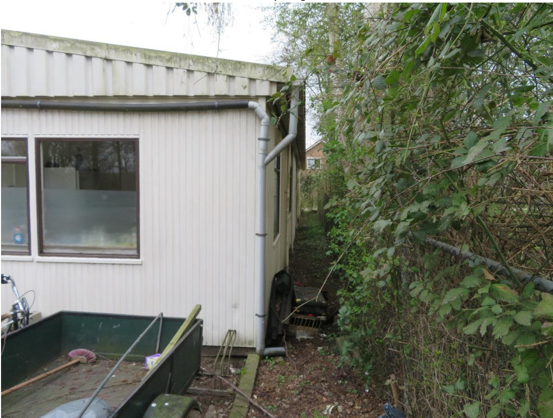
Gebouw 3, met aan de rechterzijde braamstruweel en essentieel leefgebied huismus.
