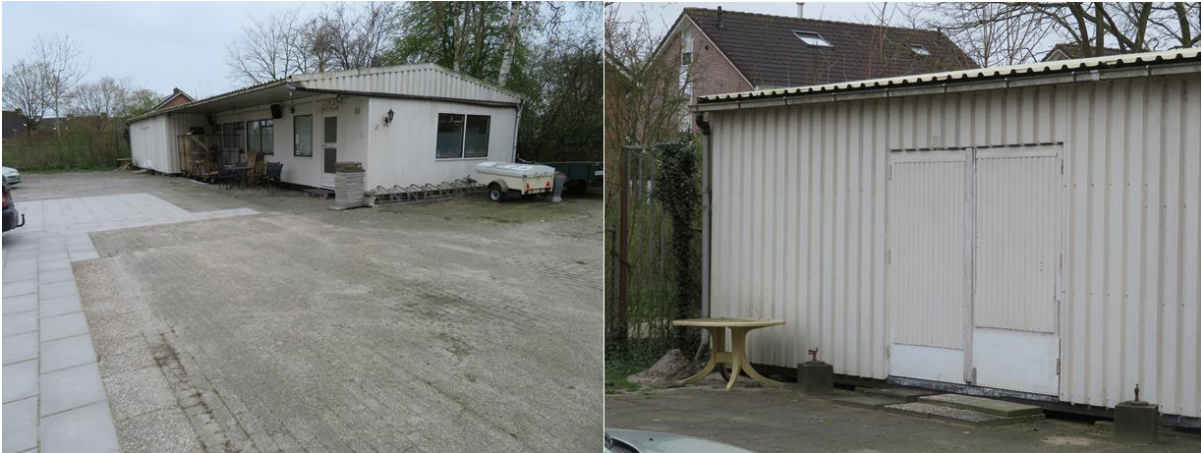
Fig 5: Het te slopen gebouw van de duivenvereniging (gebouw 3).
