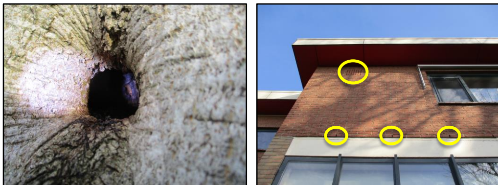
Figuur 3 Links: geïnspecteerde boomholte in esdoorn. Rechts: potentiële invliegopeningen die toegang bieden tot de spouw in het te behouden gedeelte van de woning.
