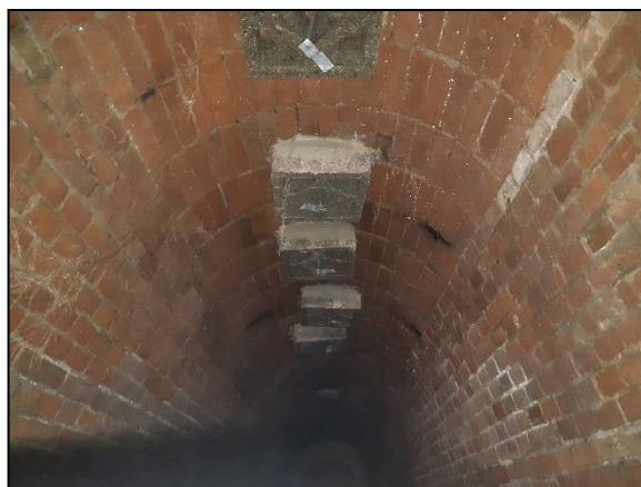
Figuur 2. Wegkruipstenen voor vleermuizen aan plafond van de gang.
