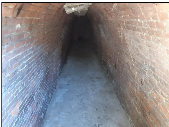
Figuur 1. Ondergrondse gang met betonnen vloer.
