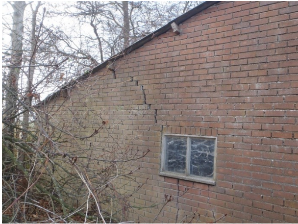
Foto 1 en 2: de beide gescheurde kopgevels van de varkensstal. Links de zuidgevel, rechts de noordgevel. De scheuren zijn 1- 2 cm breed.
