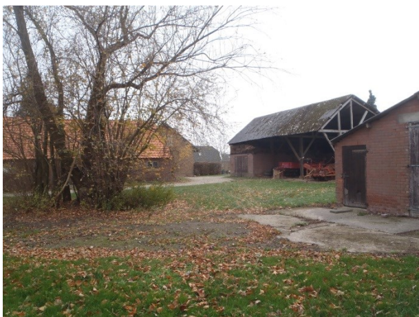
Foto 12: een kleine landschappelijke beplanting voor het ensemble van de gebouwen aan de zijde van de Eekstraat. De foto geeft een goed beeld van de inrichting van het terrein.
