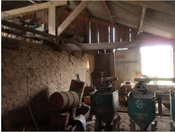
Foto 5: binnenzijde werktuigenberging van de kapschuur. De dakplaten van de schuur op de houten gebinten zijn zichtbaar. Links op de foto bevindt zich het plafond boven de garage. De muur op de foto is enkel steens. Aan de linkerzijde is de kapschuur open.
