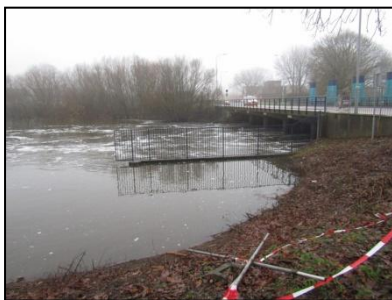
Figuur 3. Zicht op de stuw vanaf de onderzoekslocatie.
