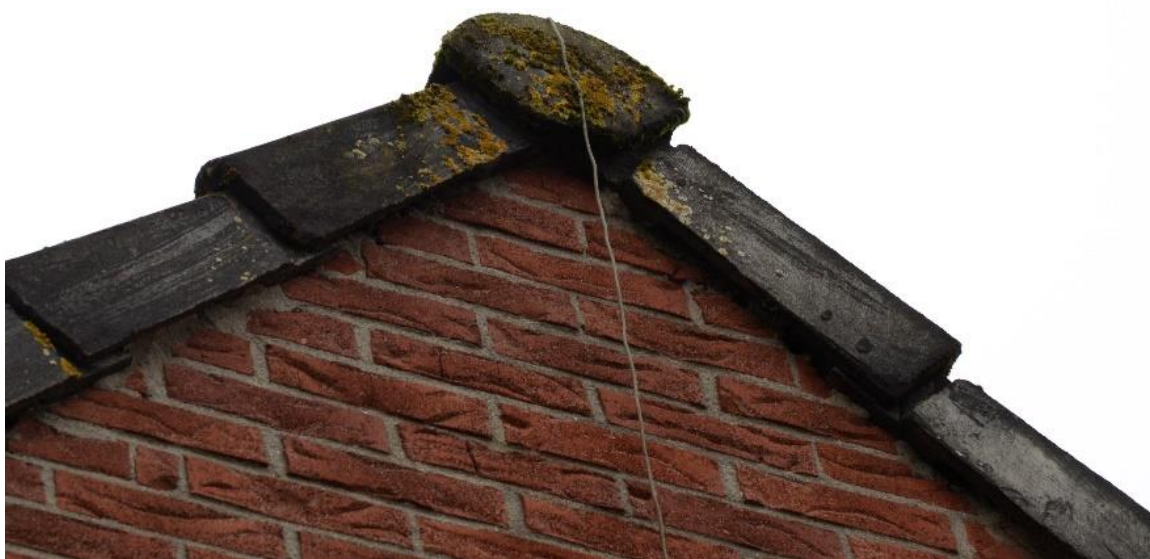
Figuur 7 Mogelijke verblijfplaats in nok van het dak.
