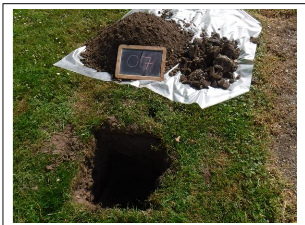
Foto: Inspectiegat bij boorpunt 07
