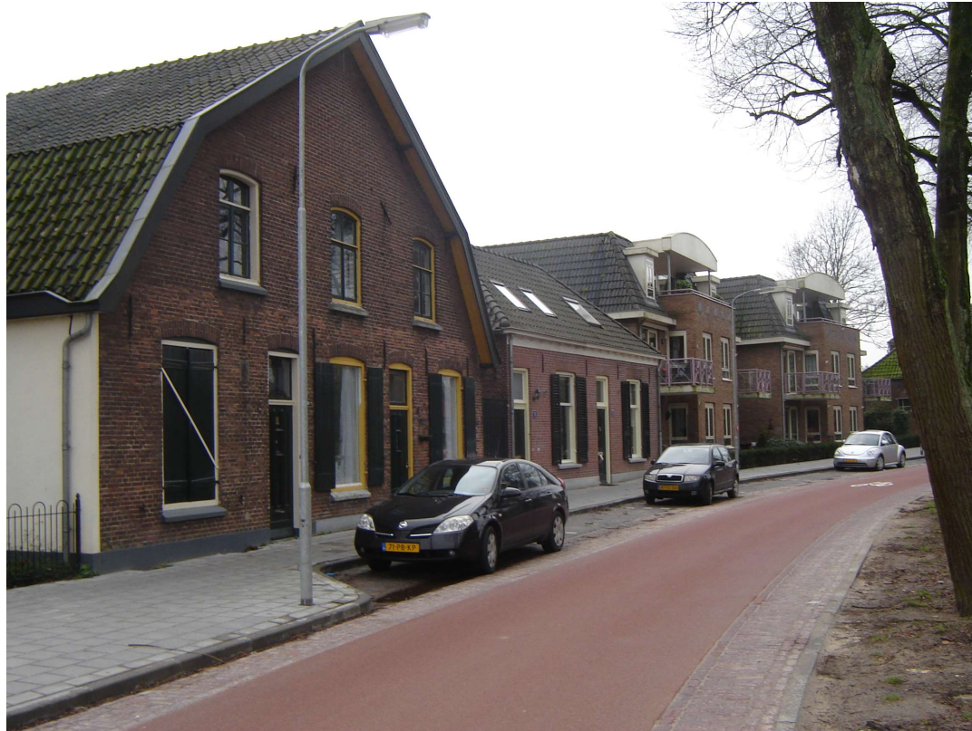
Foto 2 bebouwing aan de Loddero
