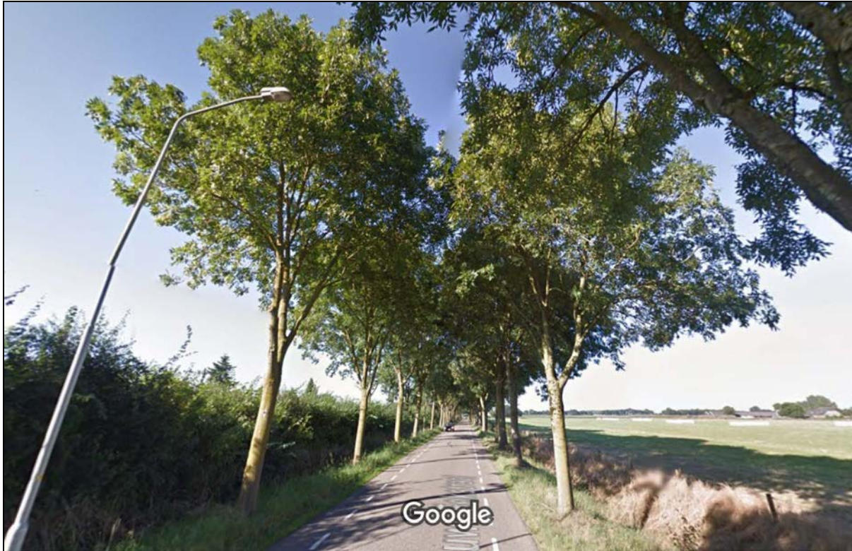
Afbeelding 31. De Nieuwe Eekstraat, met laanbeplanting aan beide zijden. Op deze foto is duidelijk zichtbaar dat de weg verhoogd is aangelegd ten opzichte van de naastgelegen percelen. Ter rechterzijde is ook de bermgreppel zichtbaar. De foto is genomen vanuit zuidelijke richting, net ten noorden van kruising met de Hettenstraat. Bron: Google Maps ( https://www.google.nl , 2018).
