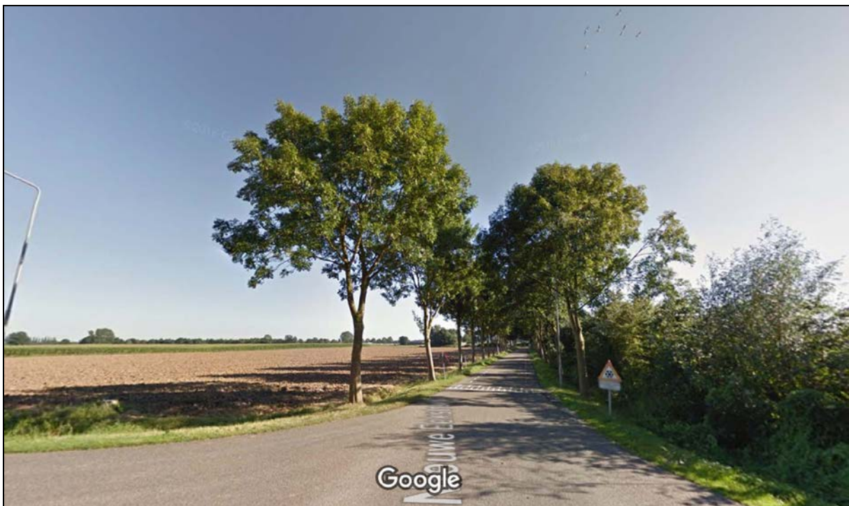
Afbeelding 32. De Nieuwe Eekstraat, met laanbeplanting aan beide zijden. Op deze foto is duidelijk zichtbaar dat de weg verhoogd is aangelegd ten opzichte van de naastgelegen percelen. Ten weerszijden zijn ook de laanbeplanting en de bermgreppels zichtbaar. De foto is genomen vanuit noordelijke richting, vanaf de kruising met de Eekstraat/ Hoefkensestraat. Bron: Google Maps ( https://www.google.nl , 2018).
