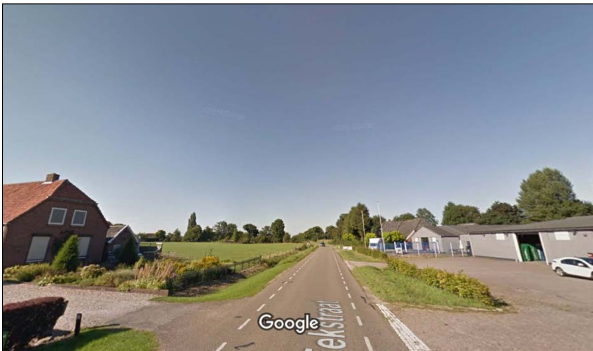
Afbeelding 30. Het zuidelijke deel van de Eekstraat, ter hoogte van nr. 1 en 2a. Op deze foto is duidelijk zichtbaar dat de weg verhoogd is aangelegd ten opzichte van de naastgelegen percelen. Ter linkerzijde is ook een bermgreppel zichtbaar. De foto is genomen vanuit zuidelijke richting, net ten noorden van de inrit van de boerderij Zomerweg 2. Bron: Google Maps ( https://www.google.nl , 2018).
