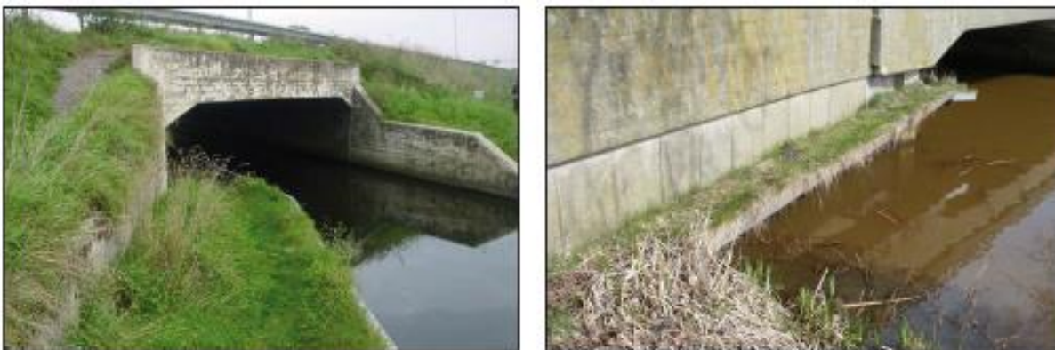
Figuur 4 Voorbeelden van permanente faunapassages met gebruik van looprichels links ca. 1 m, rechts ca. 50 cm breed (foto's E.A. Van der Grift).
