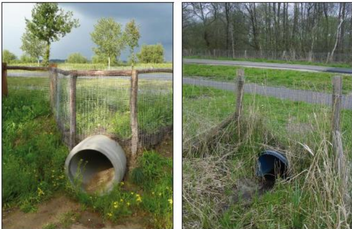
Figuur 3 Voorbeelden van faunapassages met gebruik van eco-duikers (links diameter 80 cm, rechts diameter 50 cm) met aaneengesloten rasters (foto's E.A Van der Grift).
