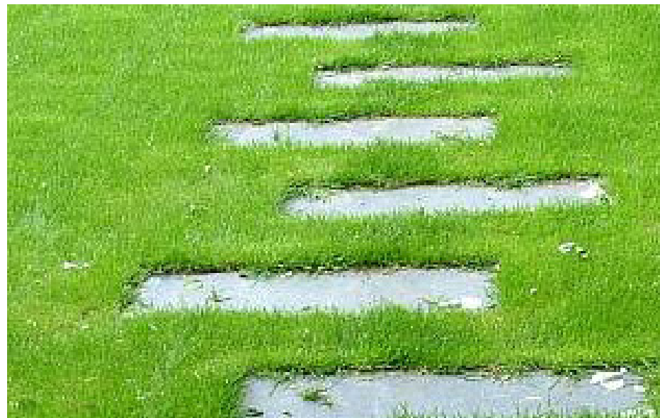
traptreden en stapstenen wadi: betonbiels 30x100cm antraciet
