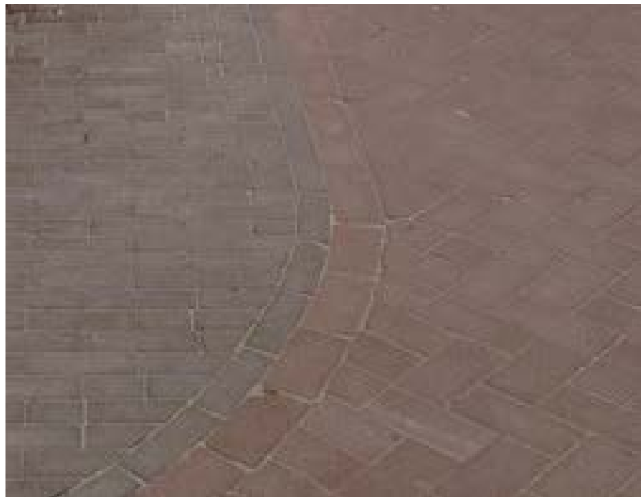
Toepassing van betonklinkers in rood/bruin/paars. Onderscheid functies (rijden, wandelen, parkeren) in verschillende kleuren, verbanden en formaten
