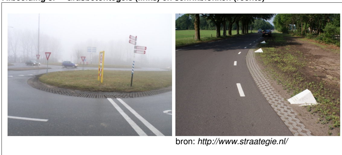
Afbeelding 8. Grasbetontegels (links) en schrikblokken (rechts)
