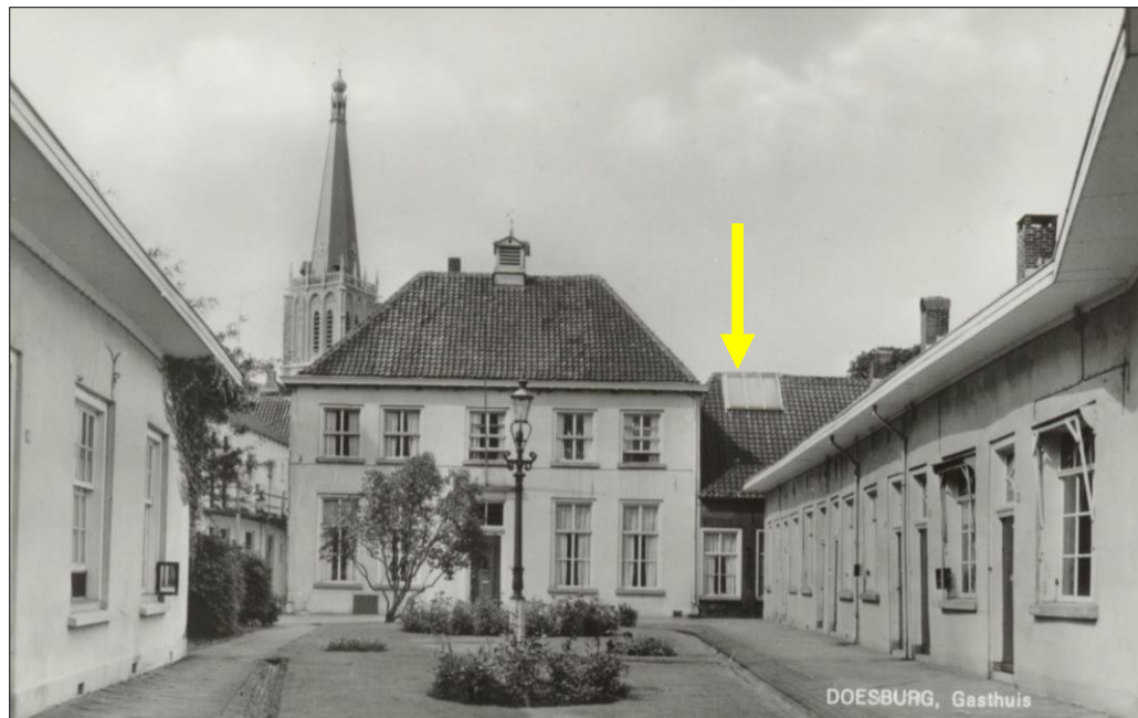
Archieffoto bouwhoogte bestaande bebouwing te verbouwen gebouw
