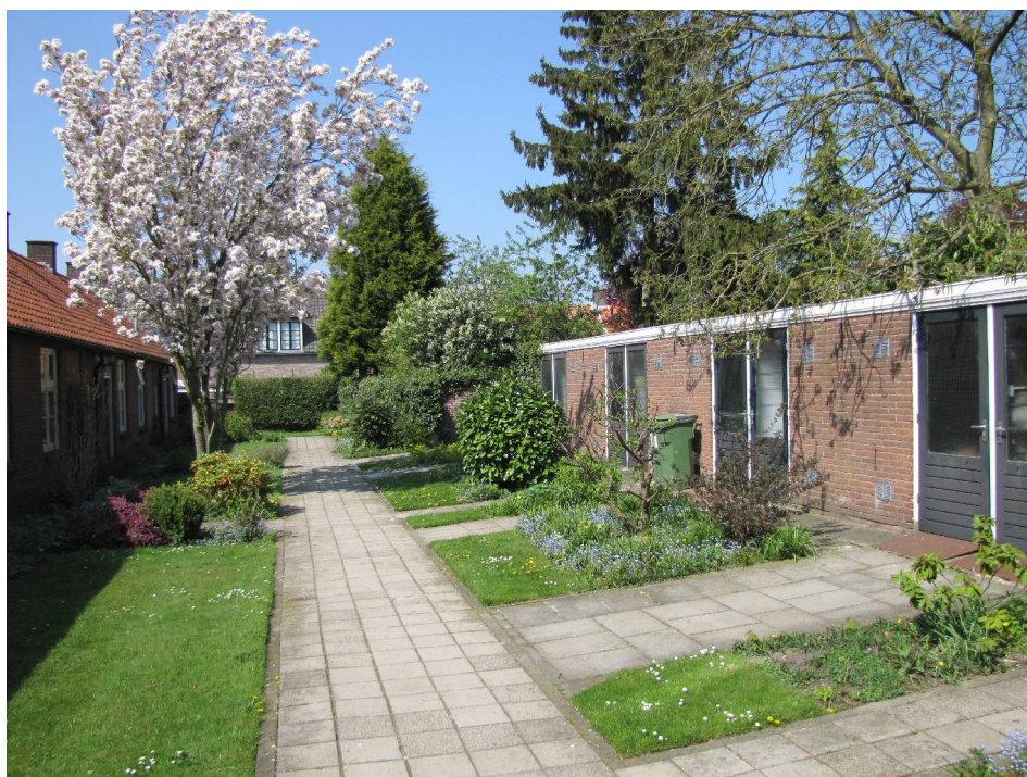
Afbeelding 2. De te slopen schuurtjes.
