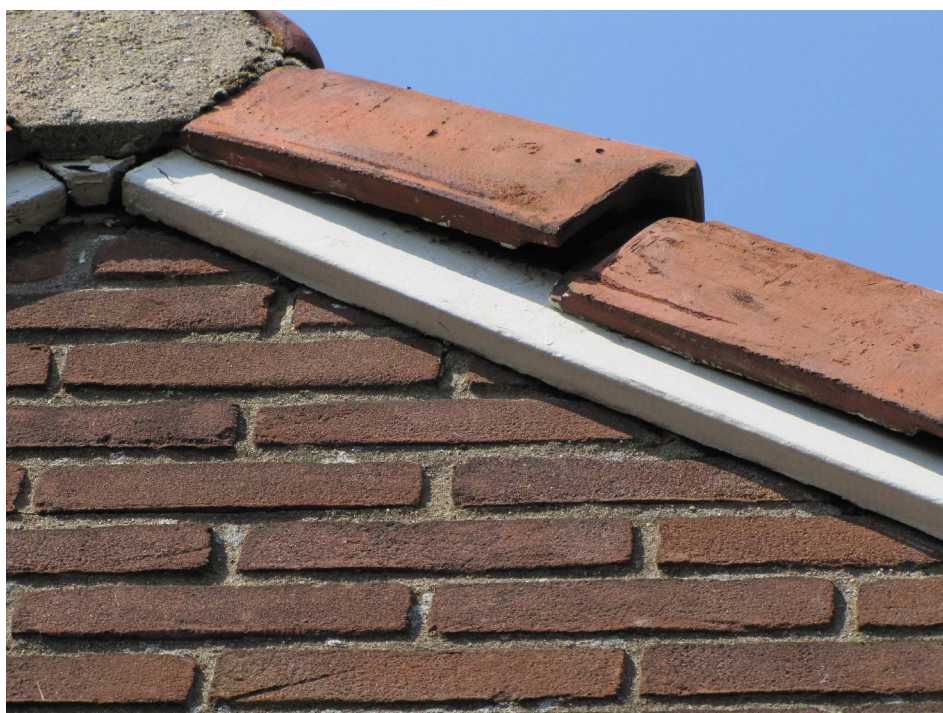
Afbeelding 4. Geschikte invlieg opening voor vleermuizen, gierzwaluw of huismus.
