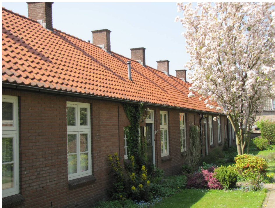
Afbeelding 1. De te slopen woningen.
